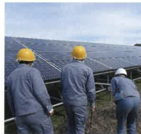
27日AM パネルの点検
