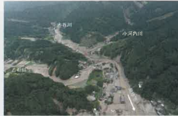
2017年の九州北部豪雨による被害 福岡県朝倉市の赤谷川、小河内川、乙石河合流点付近における流木の被害(7月8日撮影) 出典:国土交通省 平成29年7月九州北部豪雨による土砂災害の概要<速報版>vol.6(2017)
