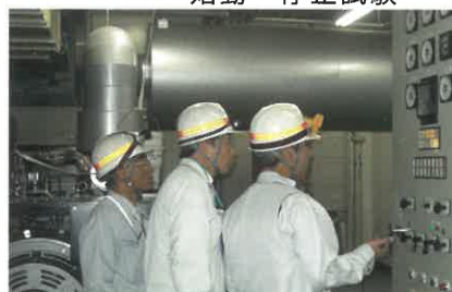
6. 非常用発電機始動・停止試験
