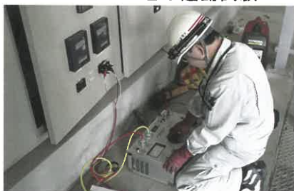
5. 保護継電器と開閉器との運動試験
