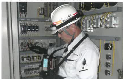
5. 保護継電器と開閉器との運動試験
