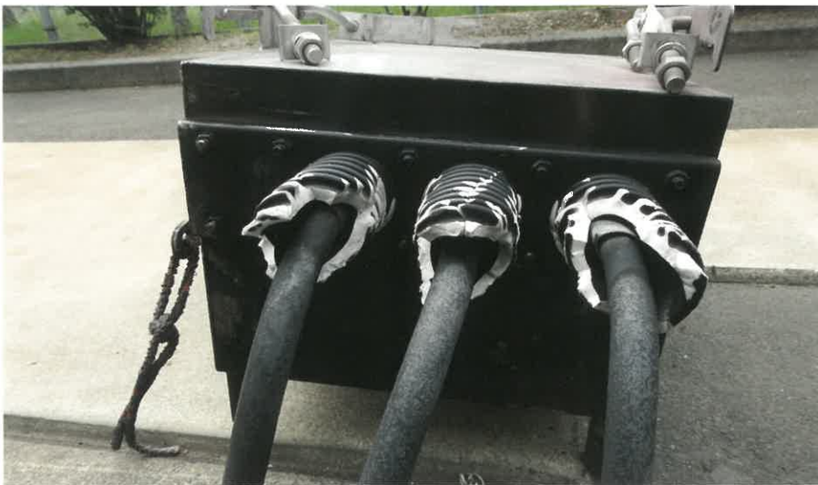
カラスによるPGS一次側短絡事故の写真
