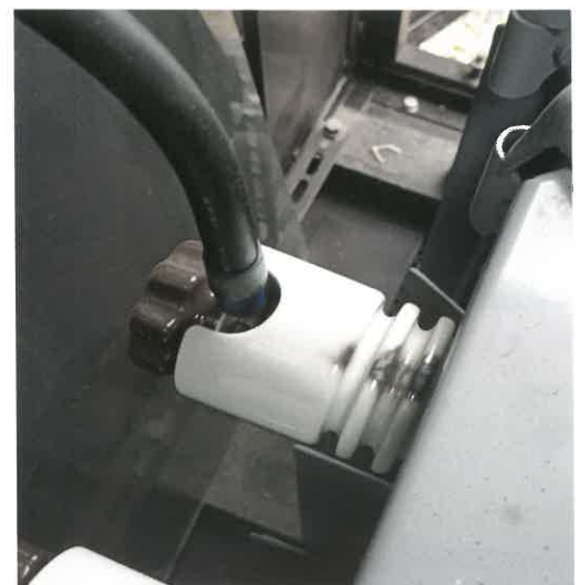
落雷による高圧パワーヒューズの溶断と放電の痕跡
